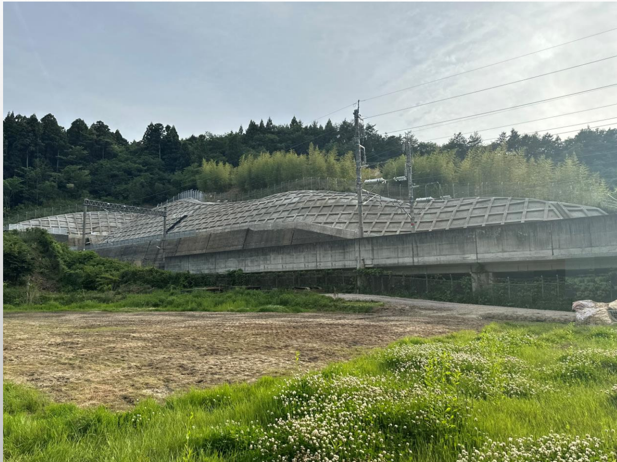
【長距離圧送吹き付け完了】
