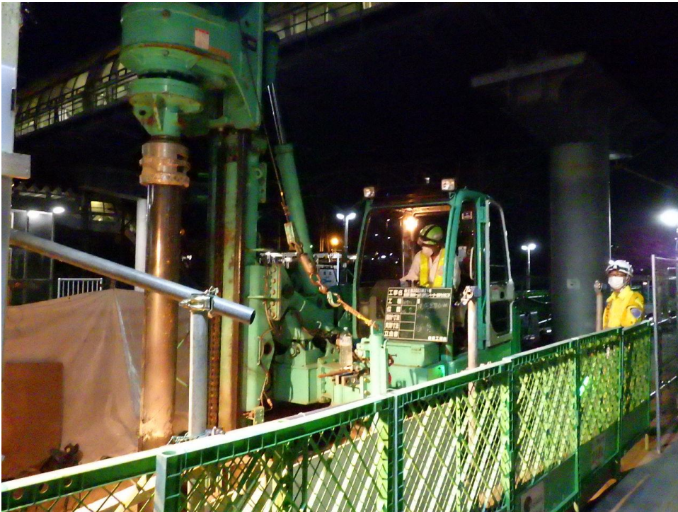
A駅（エコパイル工法）
