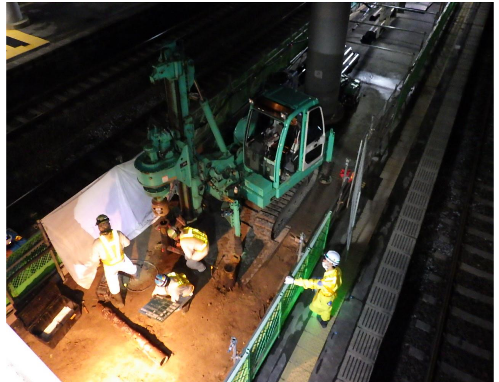
ホーム上での基礎杭施工写真
