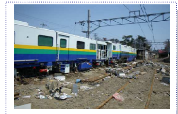
保線用モーターカーの冠水
