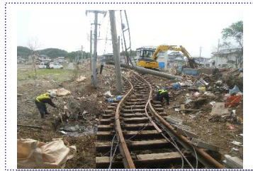
瓦礫の撤去状況(仙石線)
