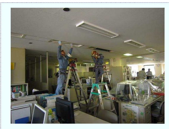
LED照明への交換
