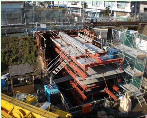
橋台部施工状況
