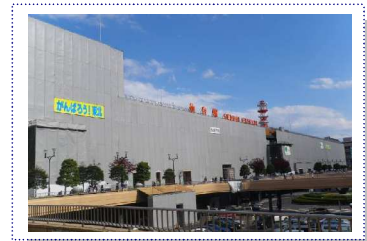
仙台駅復旧状況
